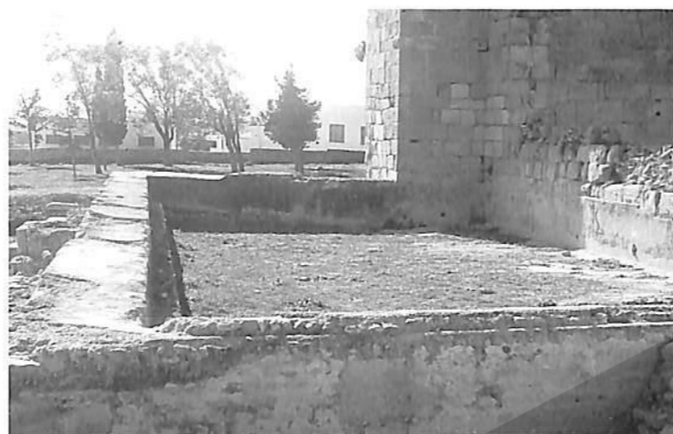
Fig. 11 : Réservoir du fort de Lemsa (Tunisie).
